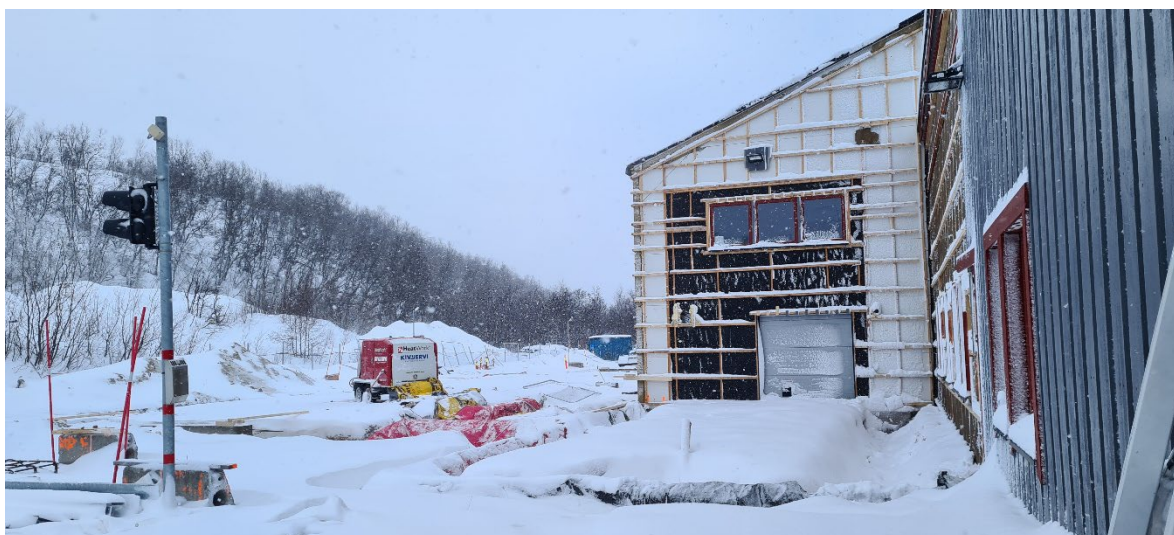
Utbyggingen igangsettes med riving før man kan bygge opp.
